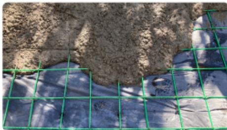
5. Hormigonado — puede utilizar el mismo método de atado que para las barras de acero.
